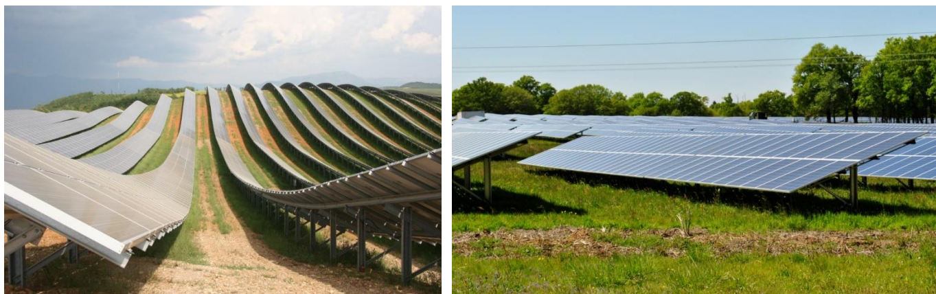
Exemple d'adaptation terrain - source : Mairie Les Méés Exemple de vue proche (source : ENCIS)
