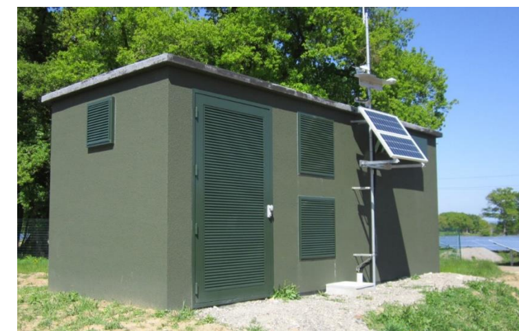
Exemple d'un local peint en vert sombre
