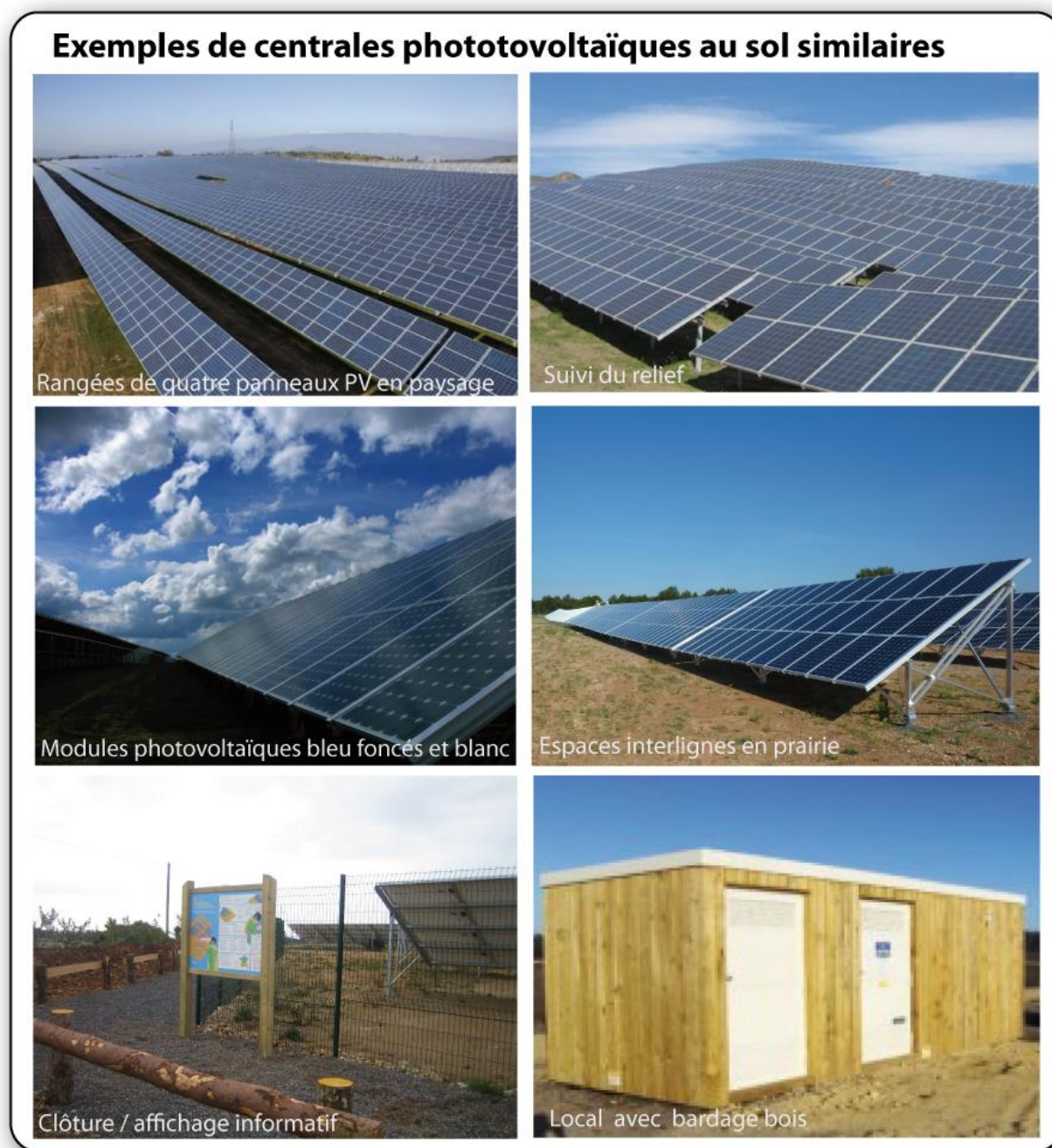
Photographie 64 : Exemples de centrales photovoltaïques au sol.
